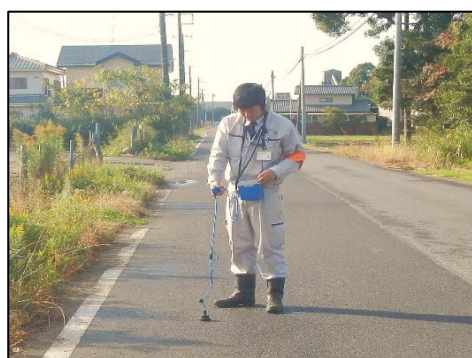
漏水調査（音聴検査）
