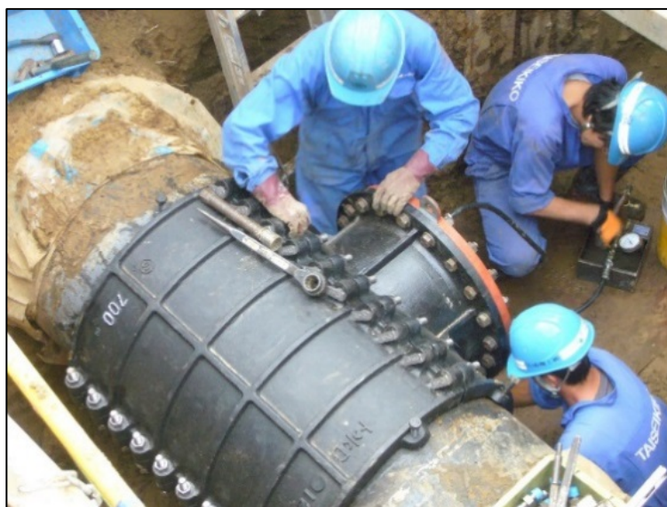
場内連絡管改良工事
