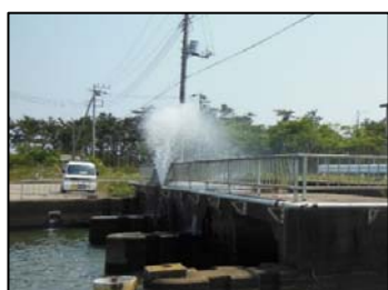
漏水状況(水管橋)
