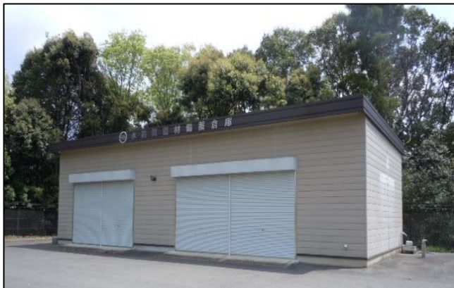
水道資器材備蓄倉庫
