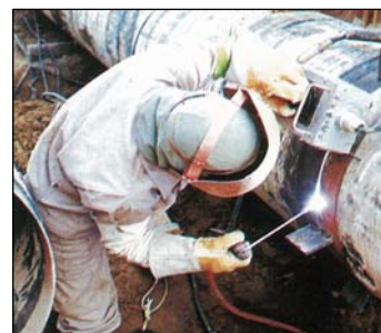
創設事業 (水道用鋼管口径600mm)
