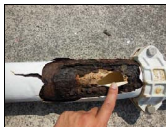
漏水箇所の拡大図(配水管腐食)
