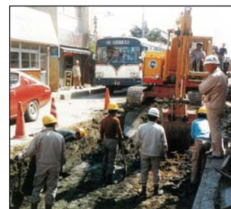
配水管整備事業
