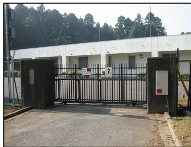
成東配水場を廃止しました。 (令和4年3月31日)
