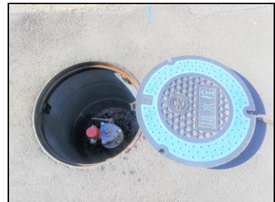
⑧排水栓点検調査
