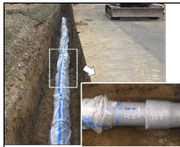
⑥基幹管路耐震化工事の様子
