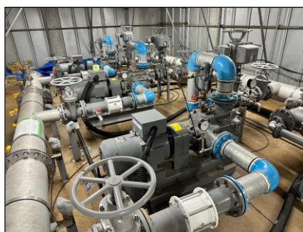
⑳東金配水場配水ポンプ設備準備工
