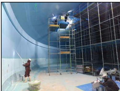
⑤東金配水場4号配水池 内面補修塗装工事の様子
