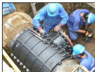
場内連絡管更新工事
