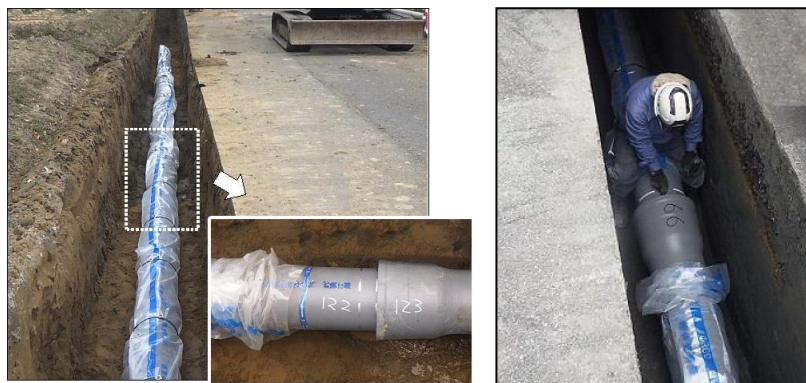
基幹管路耐震化工事
