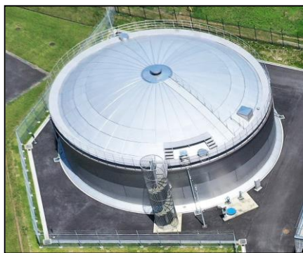
松尾配水場3号配水池
