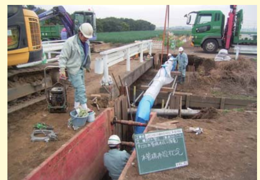
配水管改良事業(水管橋架け替工事)
