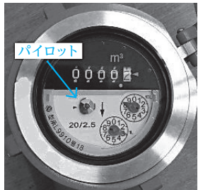
蛇口を全て閉めた状態で、メータのパイロットが少しでも回っていたら注意信号
