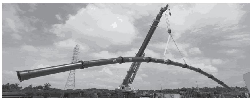
耐震化された水道管 (NS型ダクタイル鉄管)
