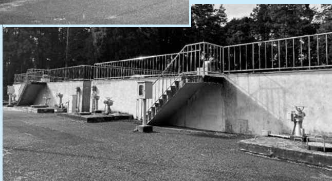
1号配水池 (右) 2号配水池 (左)
