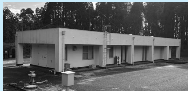
成東配水場 管理本館
