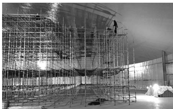
（内部）塗装作業のための足場
