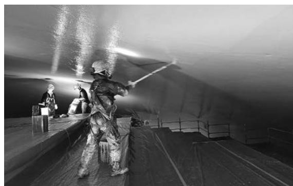
（内部）天井の塗装作業
