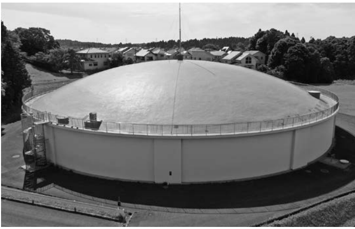
平成10年 東金配水場4号配水池完成
