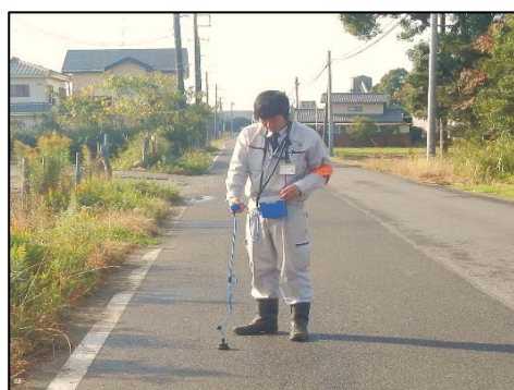
漏水調査（音聴検査）
