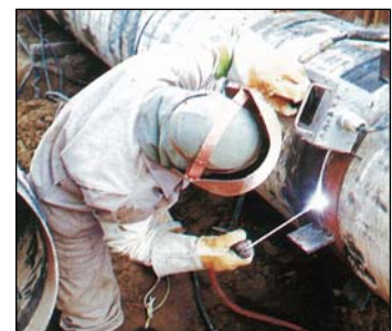
創設事業 （水道用鋼管 φ600 mm）
