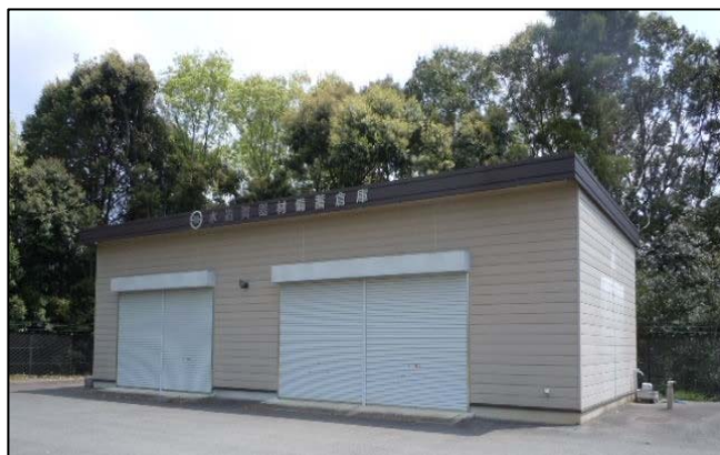
水道資器材備蓄倉庫
