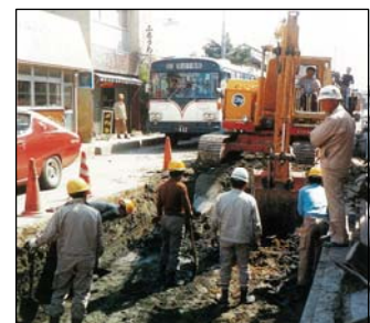
配水管整備事業
