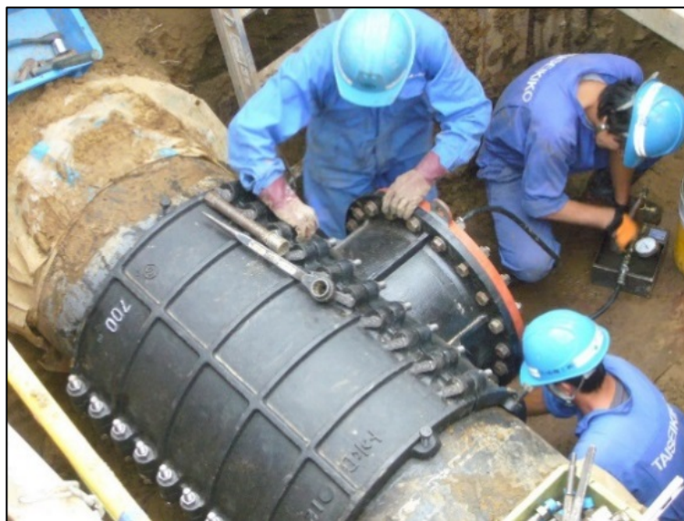
場内連絡管改良工事
