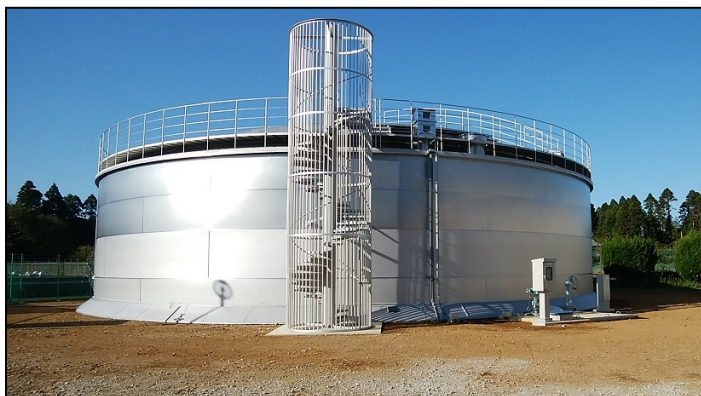
松尾配水場 3号配水池
