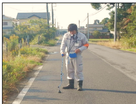
漏水調査（音聴検査）
