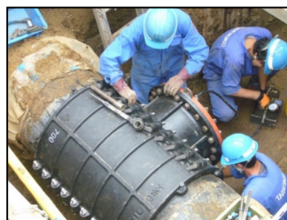
場内連絡管更新工事
